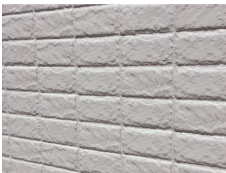
目地部分施工の良い例
