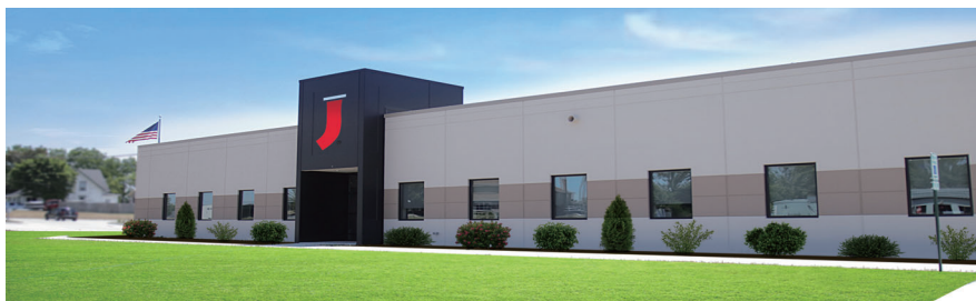
Jessup Manufacturing Company 本社
